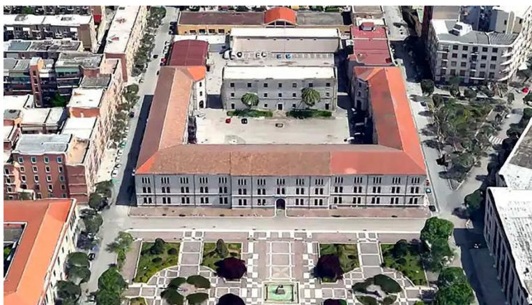
Figura 1 - Vista aerea frontale "ex Caserma Miale"
