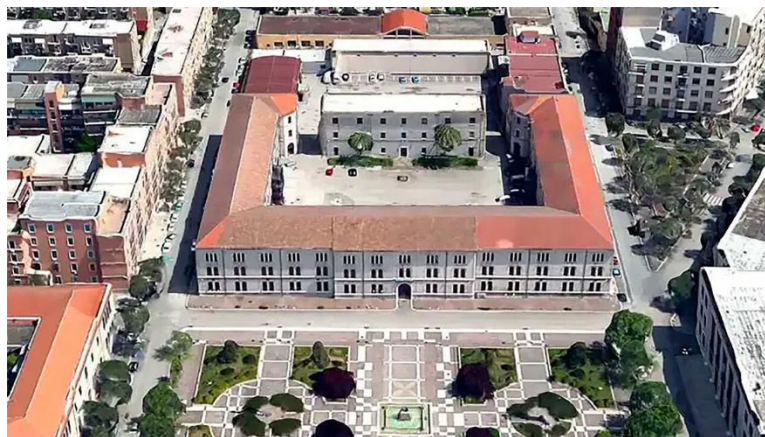
Figura 1 - Vista aerea frontale "ex Caserma Miale"
