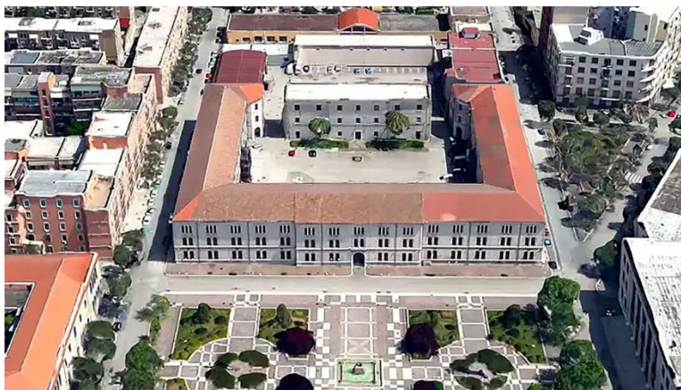
Figura 2 - Vista aerea frontale "ex Caserma Miale"
